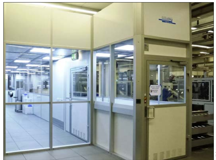
Die grossflächigen Verglasungen der Reinräume werden mittels eines silikonfreien GMP-Dicht-Clip-Systems befestigt.
